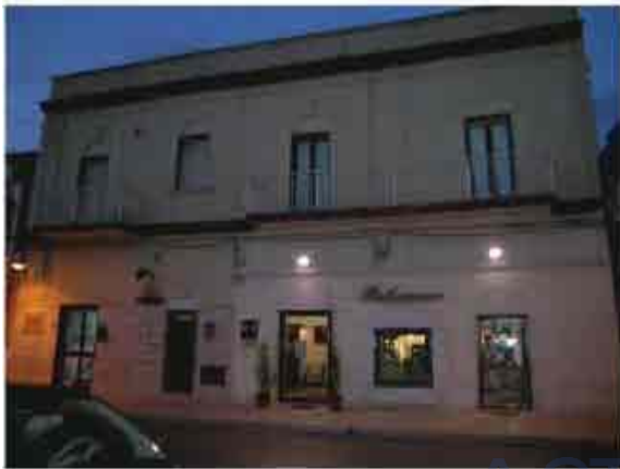
Foto 2 – Lotto 1 – Prospetto fabbricato
