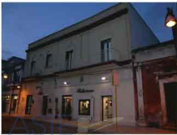
Foto 1 – Lotto 1 – Prospetto fabbricato
