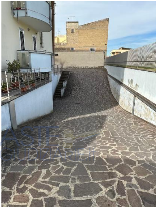
Foto n.3 – particolare rampa comune
