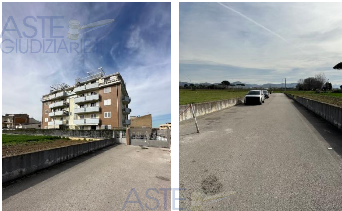
Foto n. 2 – Panoramica del fabbricato e della traversa d'accesso
