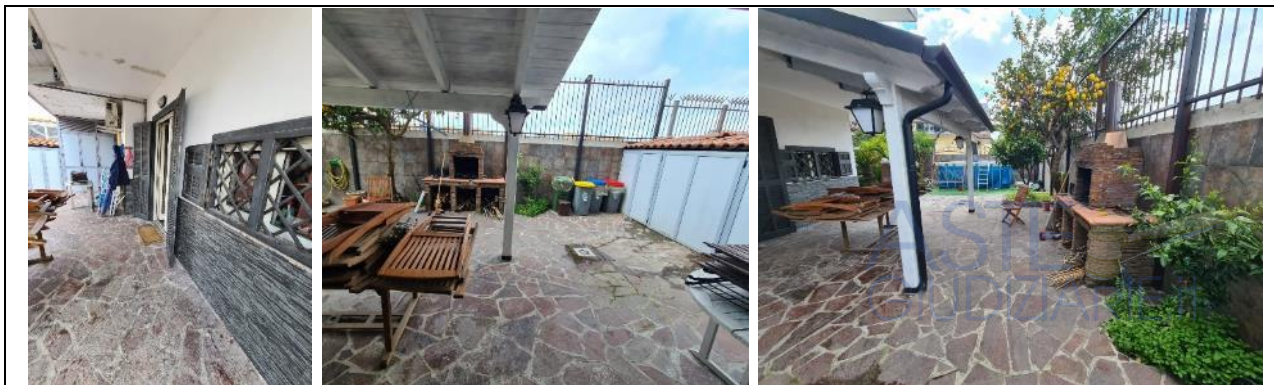
Foto 7/8/9– Vista area esterna – dettaglio tettoia e armadiature – vista esterna e muro di confine con altra proprietà
